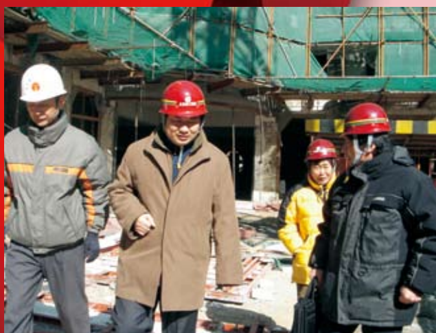
中心党委书记、副主任赵超在北理工大学学生公寓建设现场
