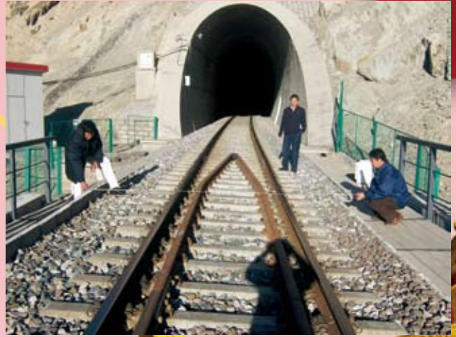
达成铁路实地勘测
